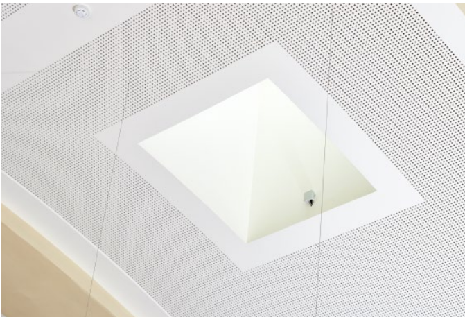
Bekleidete Deckenöffnungen reichen bis zur Dachhaut, wo ein Oberlicht integriert ist.
