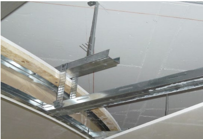
Detail Deckenvorsprung. (Foto: Ruben Peter Ausbau GmbH)
