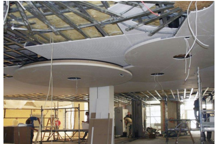
Deckenkonstruktion des Foyers mit den drei Deckenebenen in der Bauphase. (Foto: Jaeger Ausbau)
