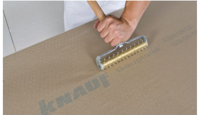
Bild 2: Platte auf Schablone legen
