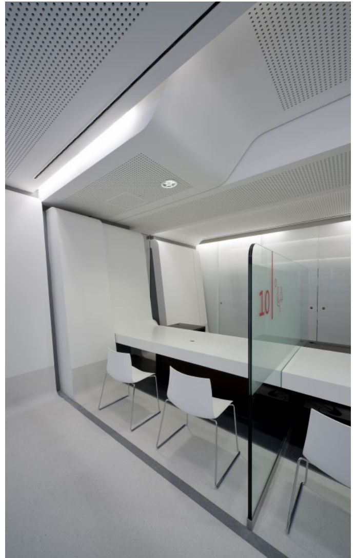
Deckenbekleidung mit Knauf Cleano Akustikplatten. (Foto: Knauf/Albert)
