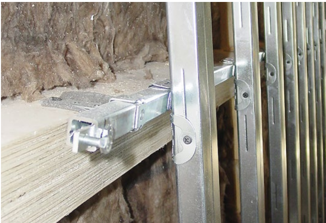
Blick ins Detail: Gebogene CD-Profile 60/27, gebogene waagerechte Vierkantrohre 20x20x2 mit CD-Profilverbindern und Abhängern für Vierkantrohre auf Filz-Trennlagen. (Foto: Knauf)
