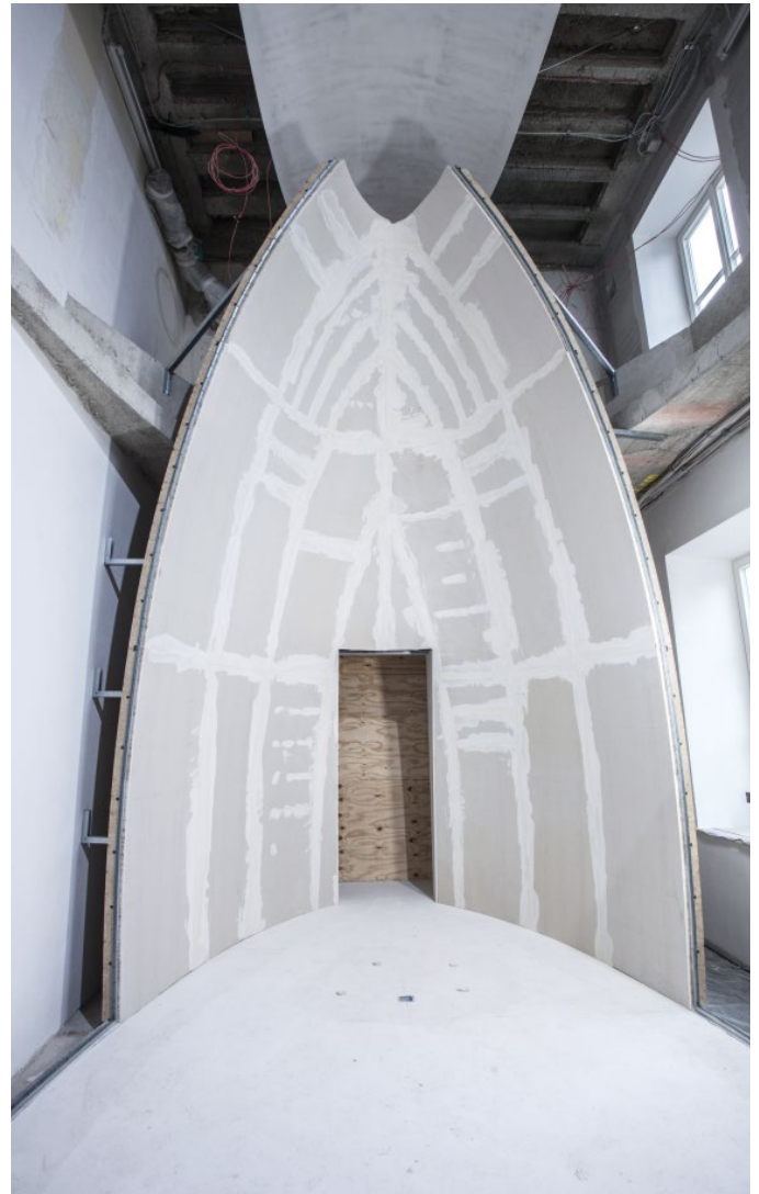
Formteile bilden ein Raum-in-Raum-System.
