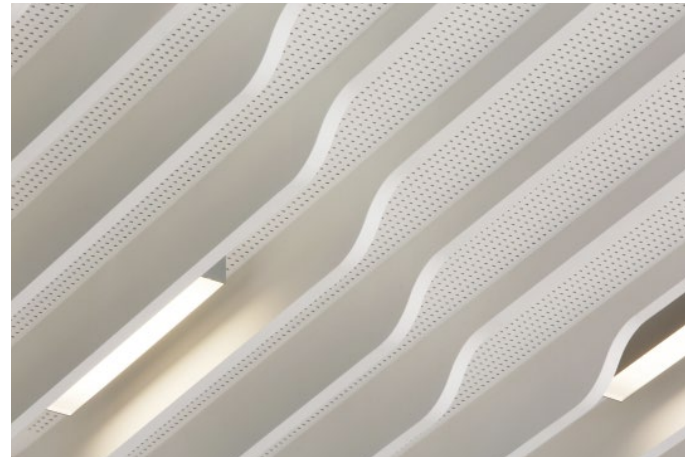
Wechselspiel von Lamellen und Lochplattenstreifen.
