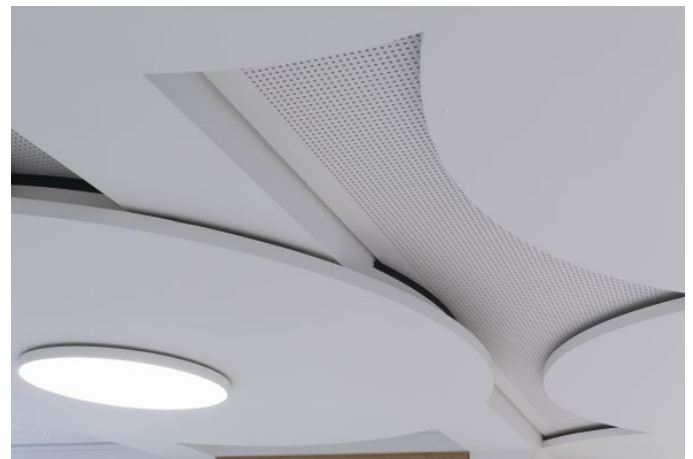
Die neue Decke staffelt sich in drei Ebenen in die Höhe und kaschiert dabei auch die tief liegenden Stahlbetonunterzüge. (Foto: Knauf/Klemens Ortmeyer)
