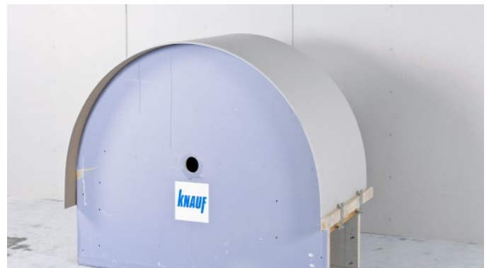
Bild 4: Platte auf Schablone fixieren
