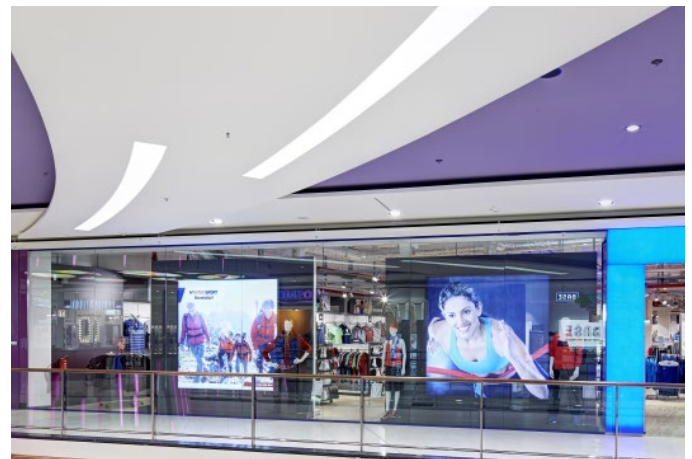
Frei geformte Deckensegel mit integrierten geschwungenen Lichtvouten setzten die Gänge und Galerien ins rechte Licht. Die Segel bestehen aus zehn bis zwölf vorgefertigten Einzelelementen.
