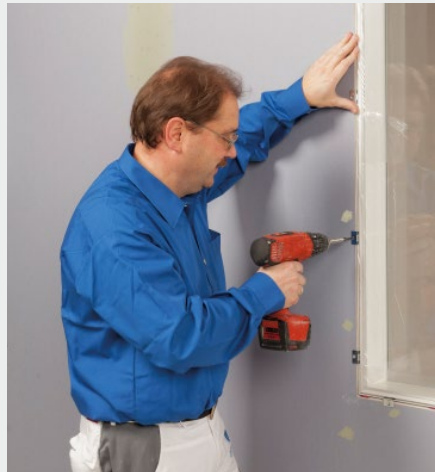
Fertigfenster verschrauben
