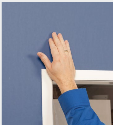
Abdeckrahmen einsetzen
