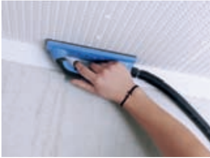
1 Leicht anschleifen
