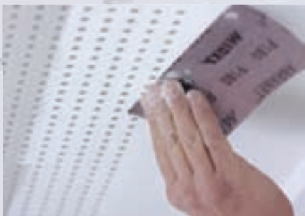
5 Übergang leicht anschleifen
